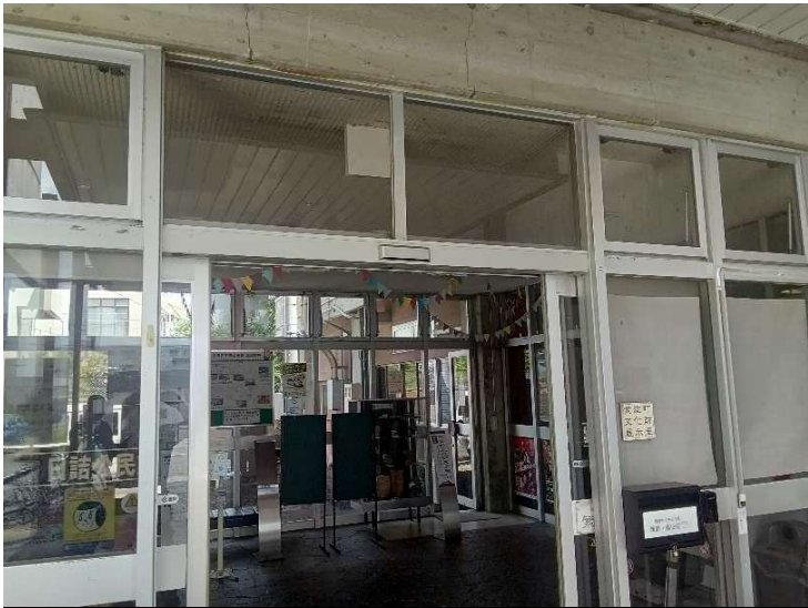
自動ドアフロント 外観
