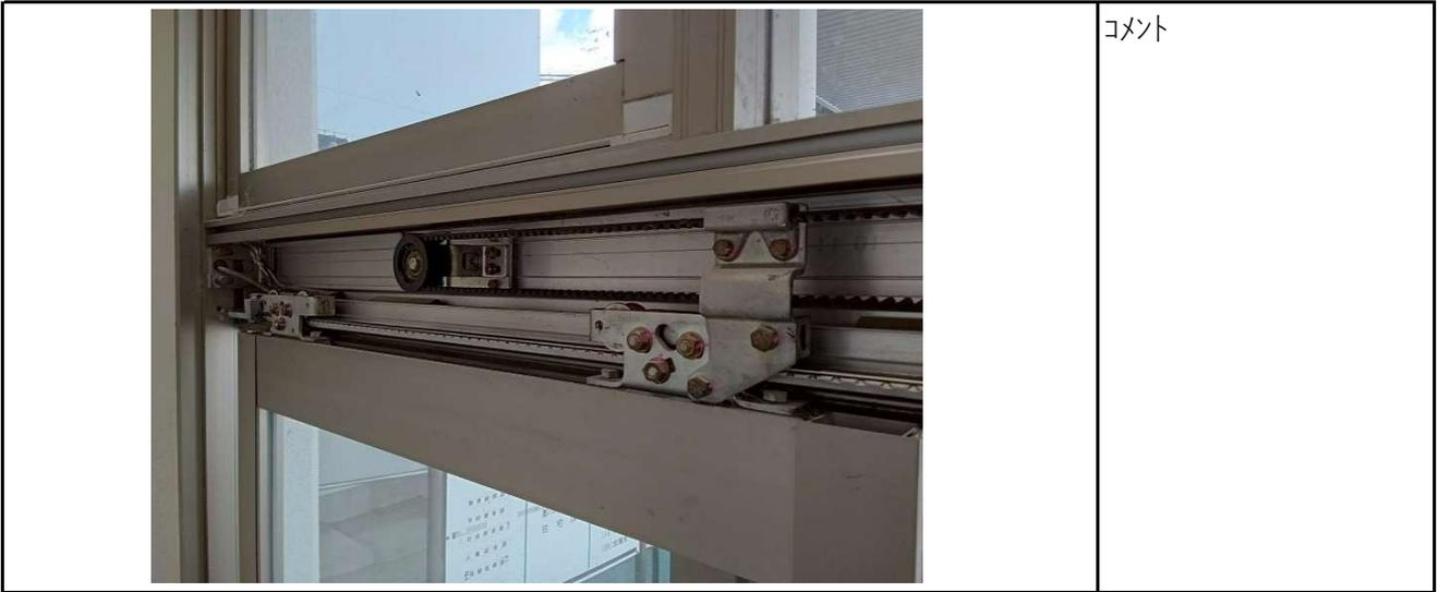
自動ドア開閉装置（装置取付状態）
