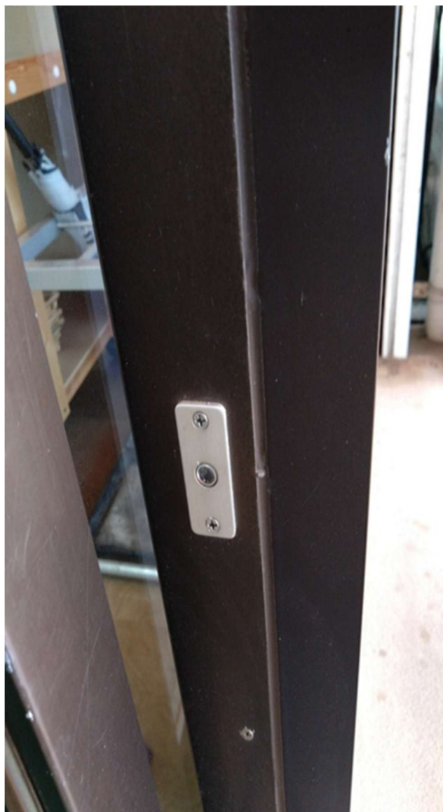
<補助光線センサ>対向1光線（プレート付き）
