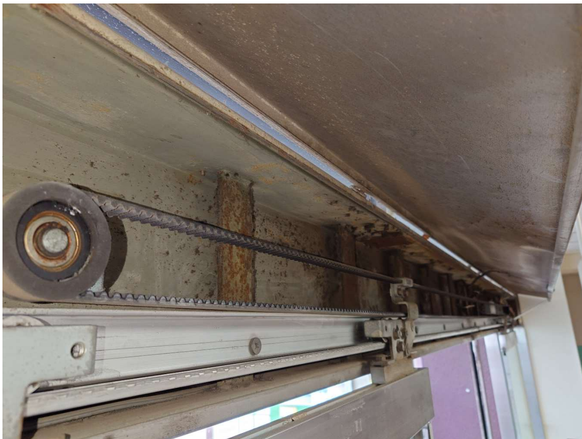
自動ドア取付納まりの様子（右側部分）
