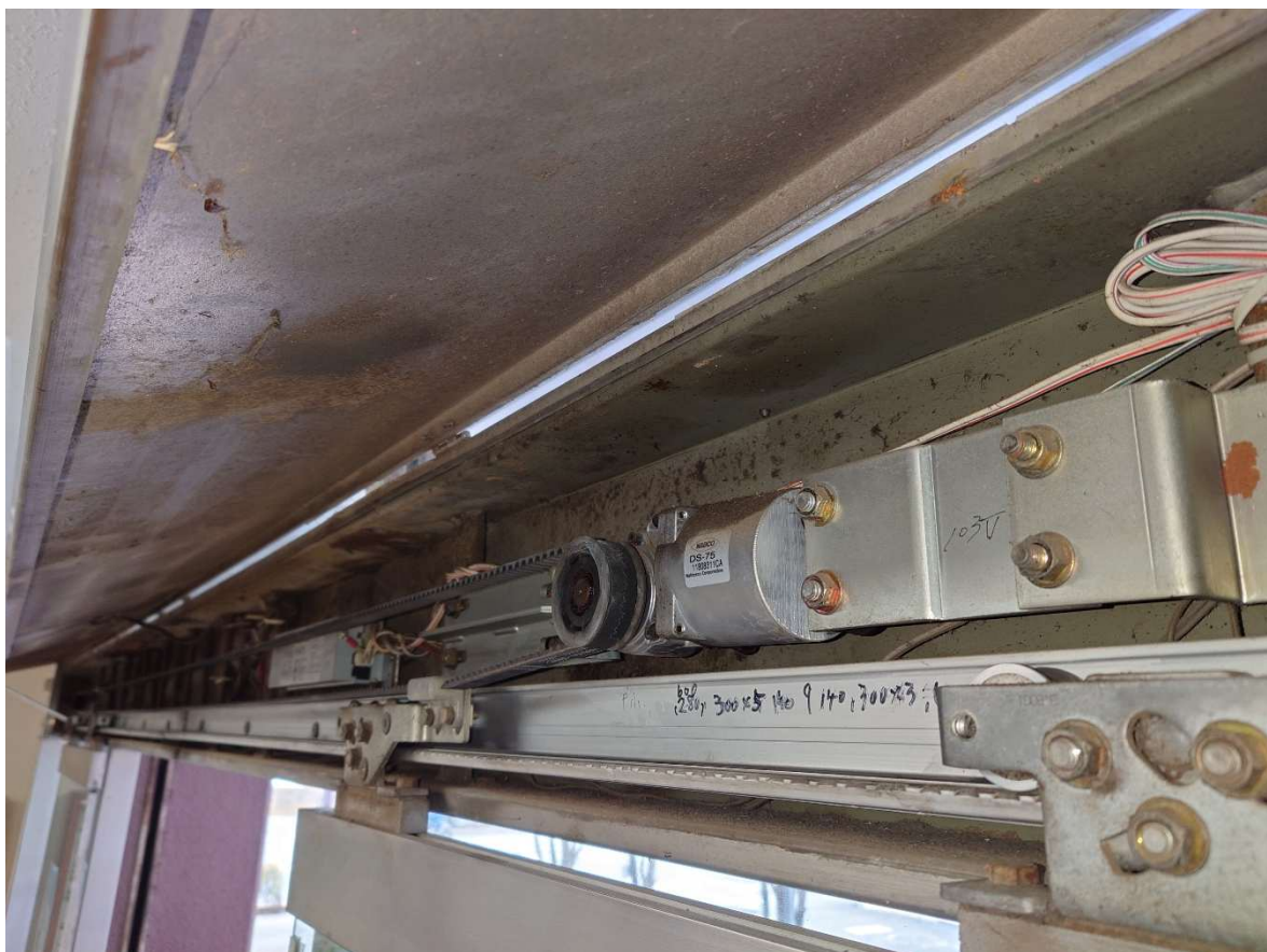
自動ドア取付納まりの様子（右側部分）
