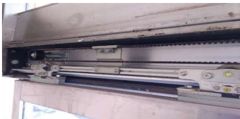
③老朽化自動ドア開閉装置撤去
