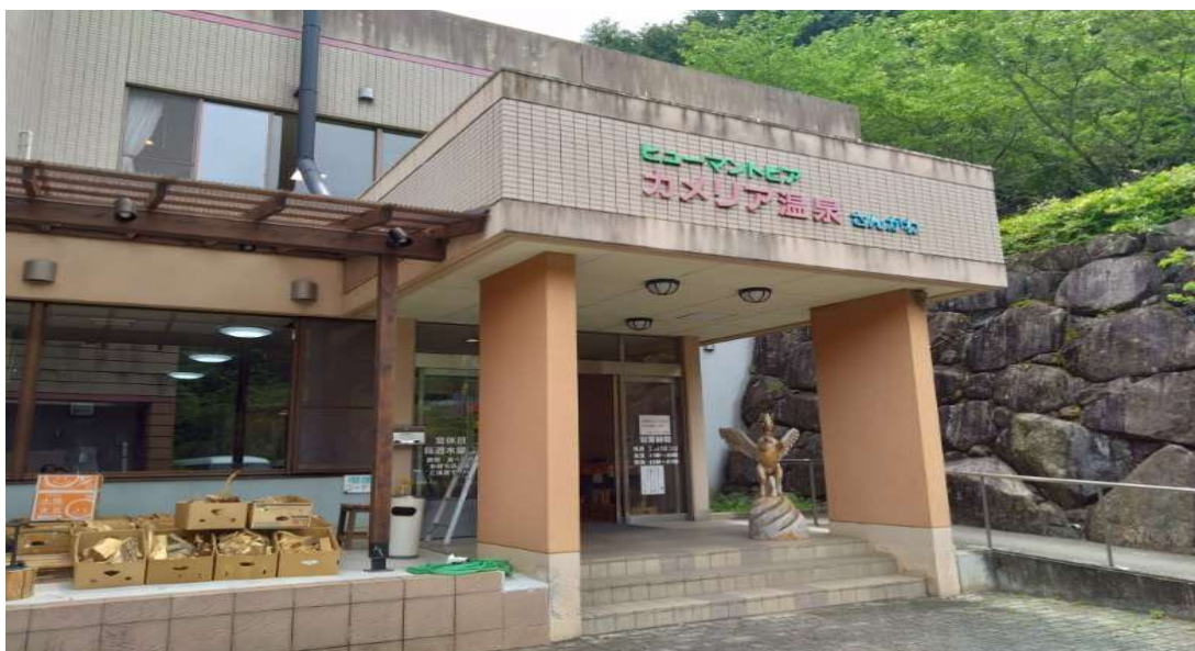
自動ドアフロント外観
