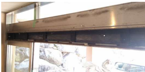
④老朽化自動ドア開閉装置撤去
