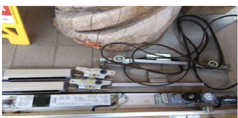
④老朽化自動ドア開閉装置撤去
