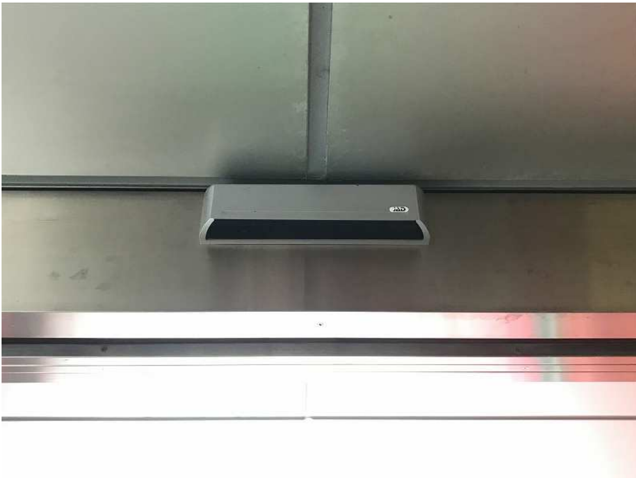
内部起動センサ（無目付けセンサ）
