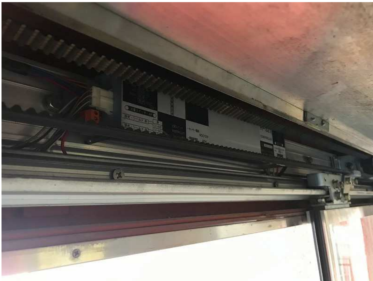
自動ドア装置内部の様子
