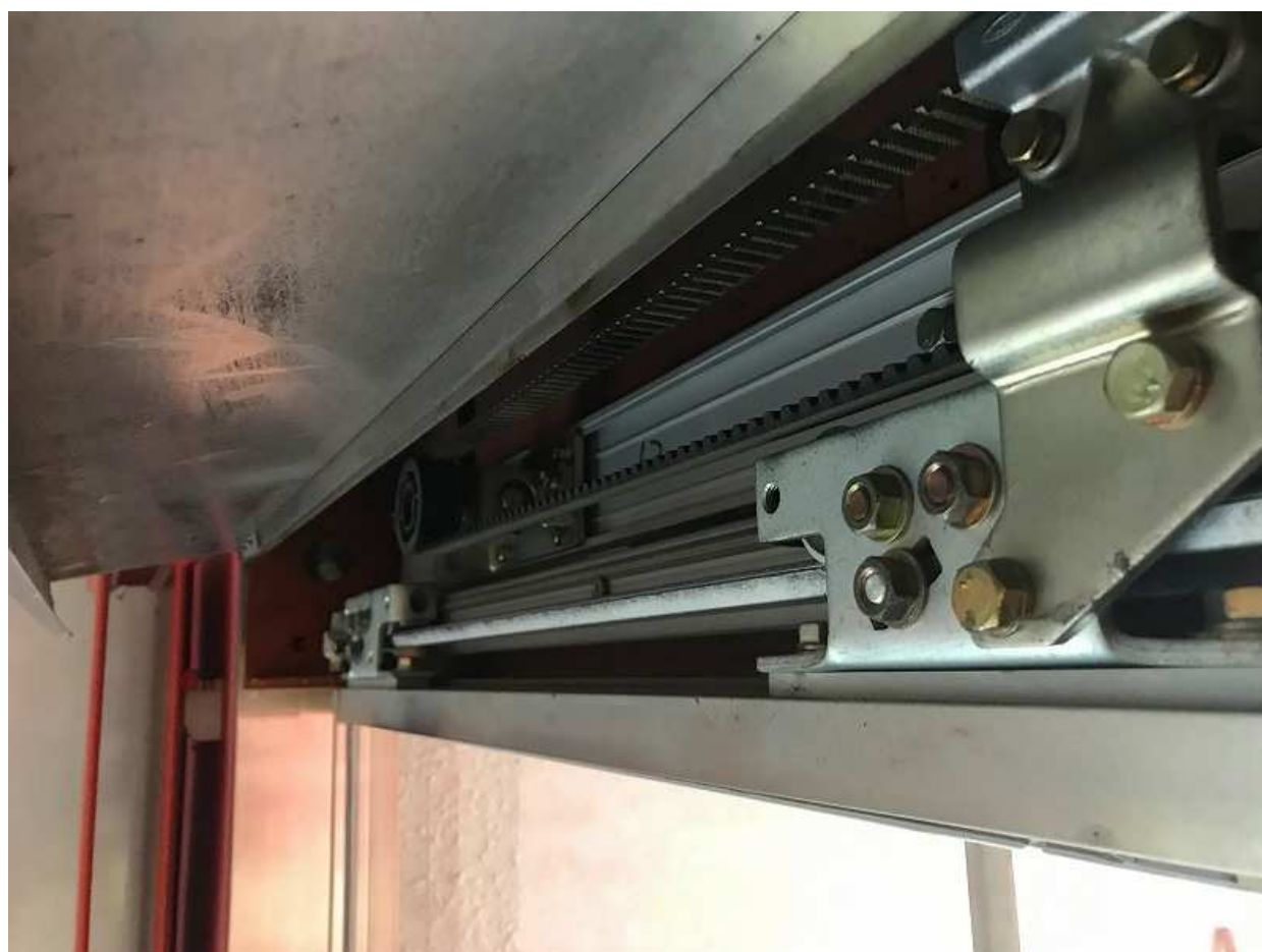
自動ドア装置内部の様子
