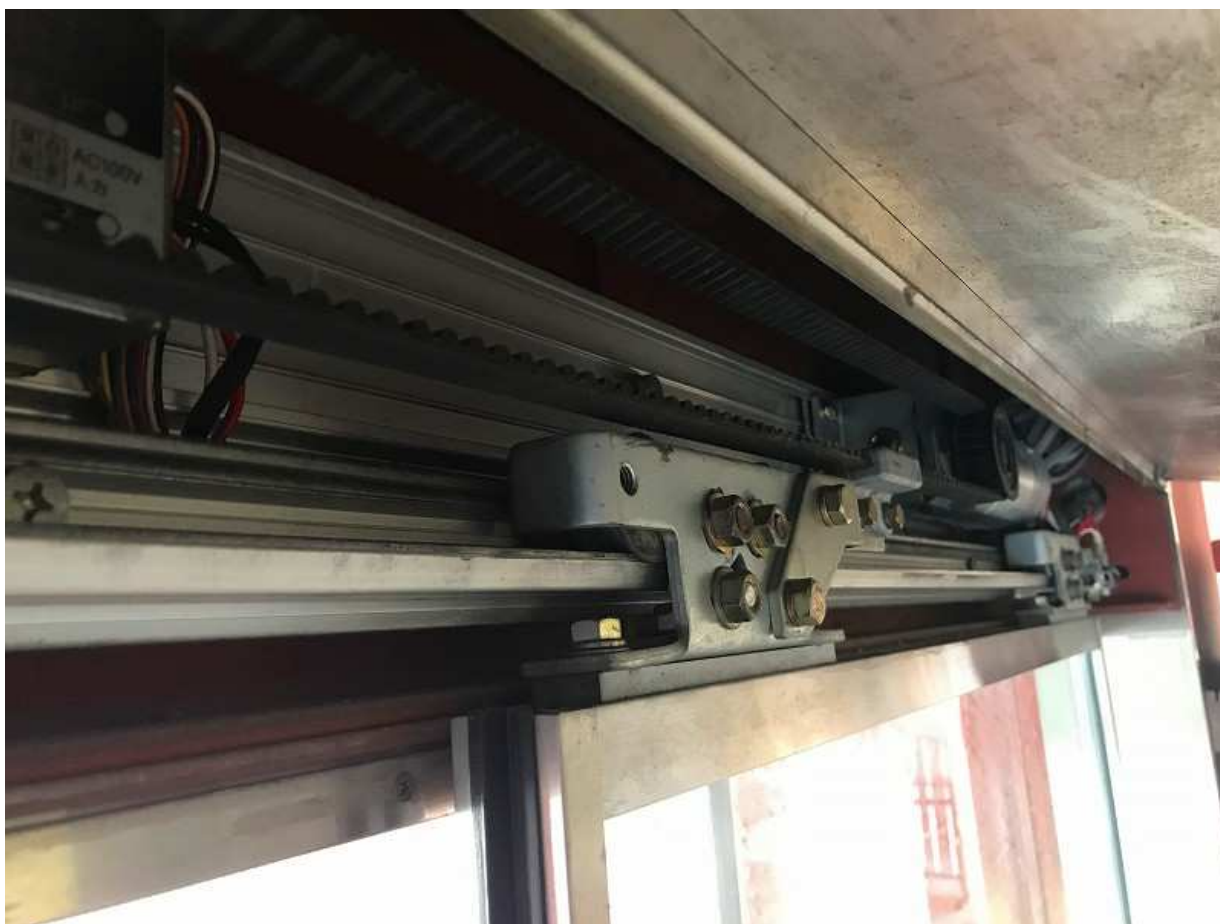
自動ドア装置内部の様子
