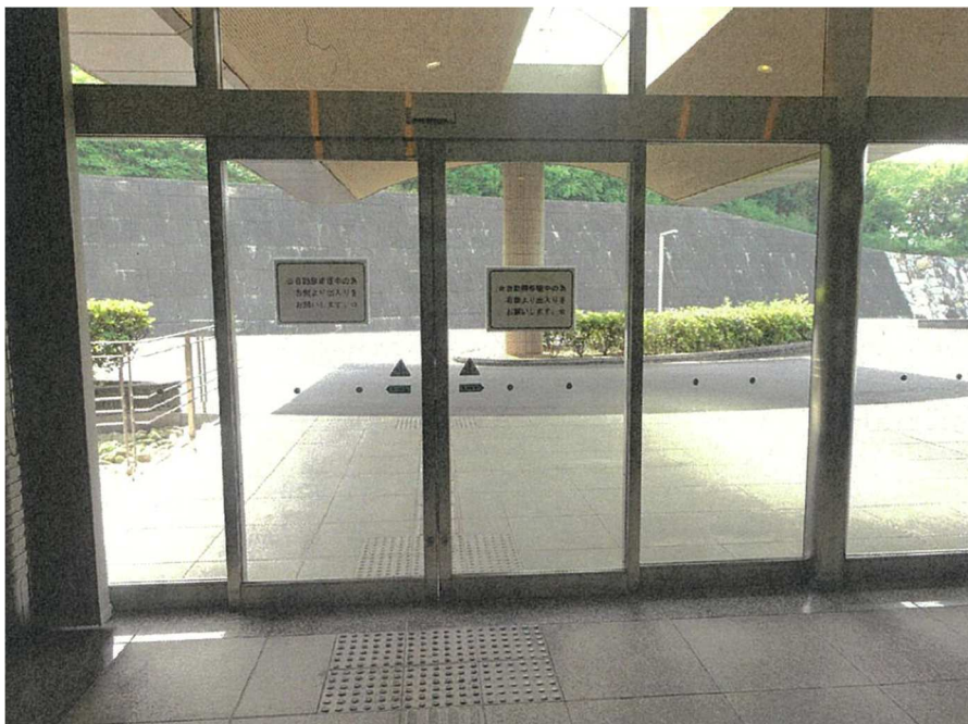
自動ドアフロント内観 SUSHL 自動ドアフロント内蔵両引き自動ドア装置
