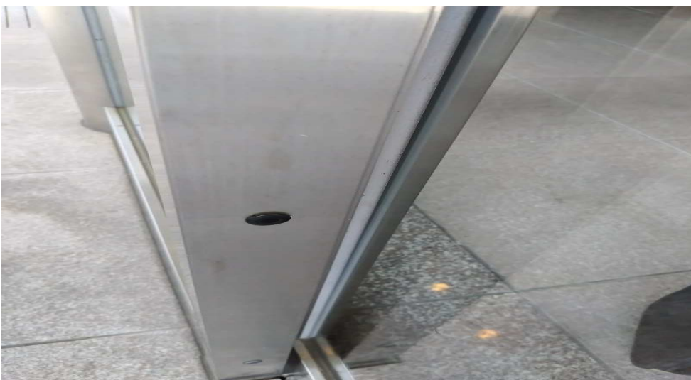
補助光線センサの様子（対向2光線）
