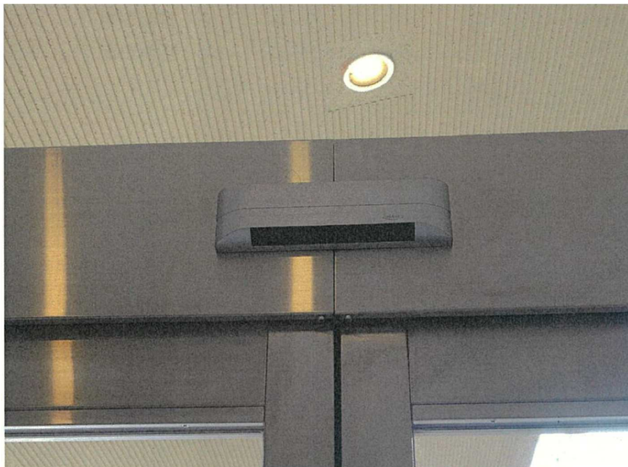
補助光線センサの様子（対向2光線）
