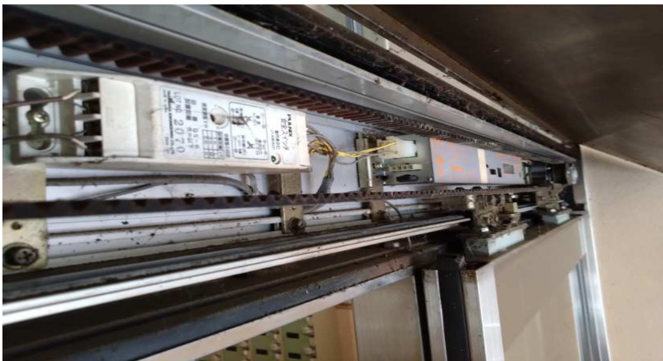
自動ドア開閉装置の様子
