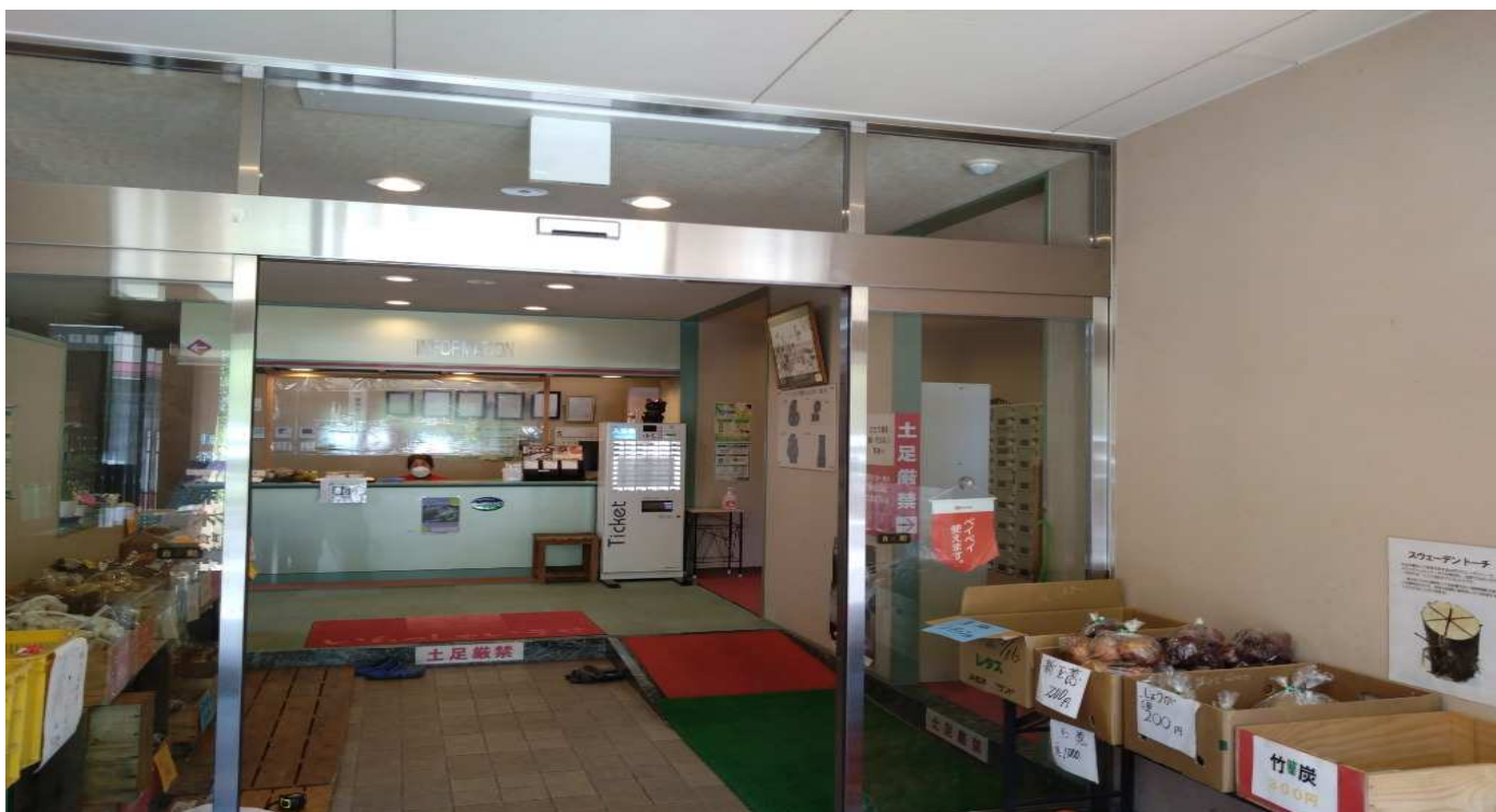
自動ドアフロント 外観 SUS HL 仕上げフロント内蔵 両引き自動ドア開閉装置
