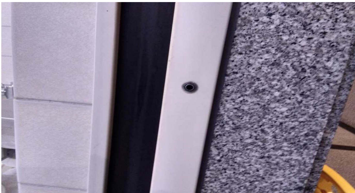
補助光線センサ（対向1光線）
