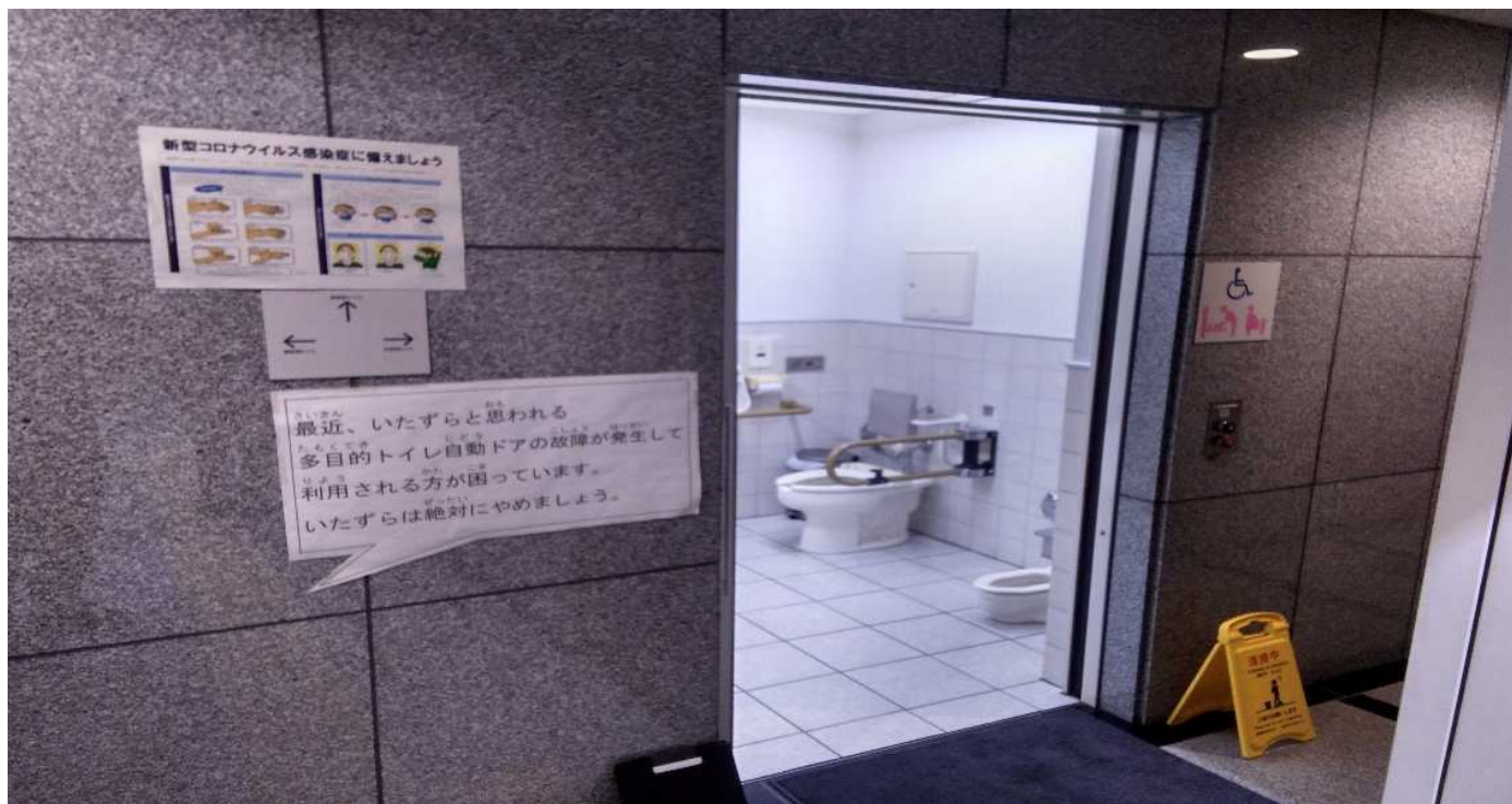
外側起動スイッチ 押しボタンスイッチ（開閉ボタンと使用中表示灯付き）
