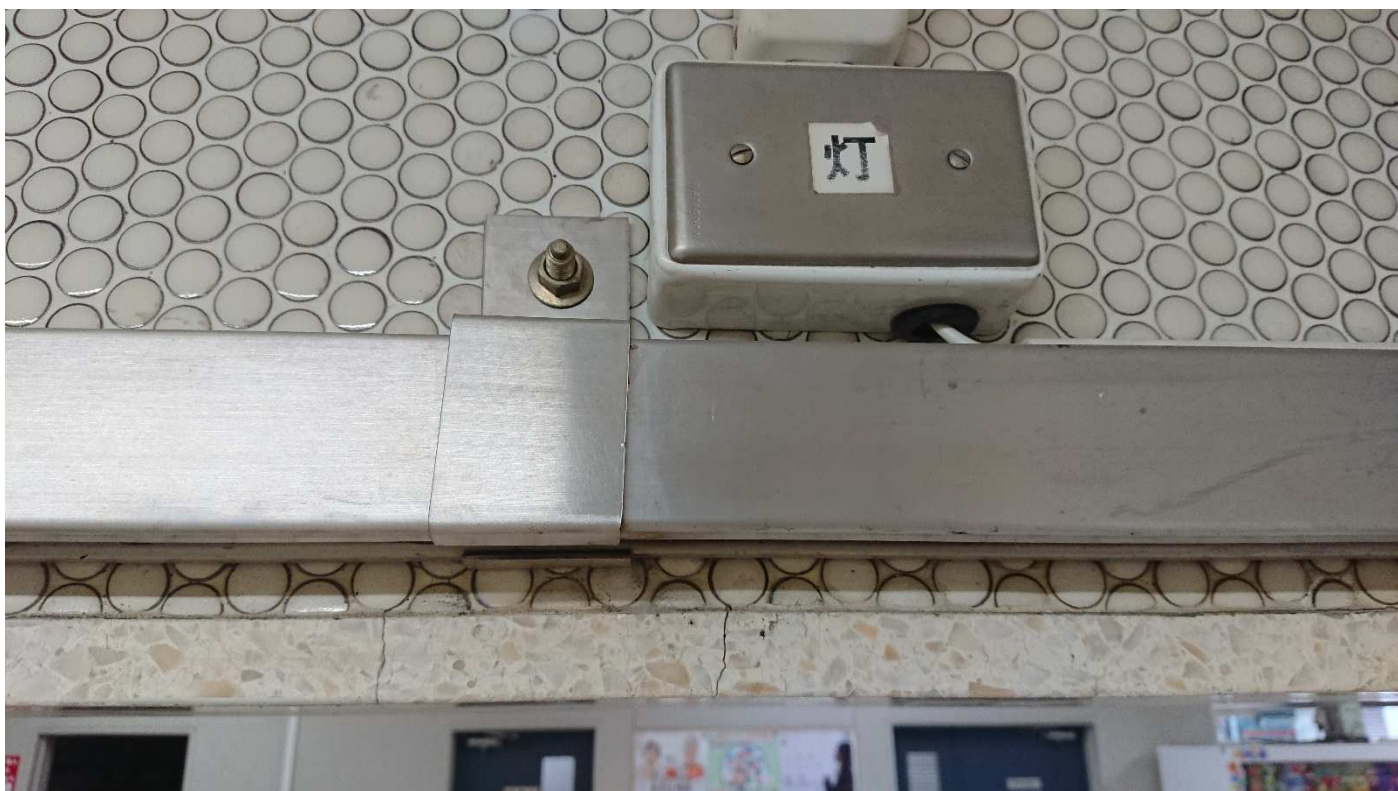
使用中表示灯配線接続用スイッチボックスの様子
