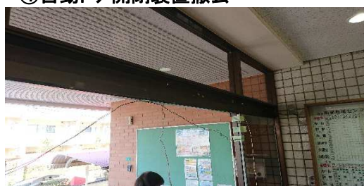
④自動ドア開閉装置撤去
