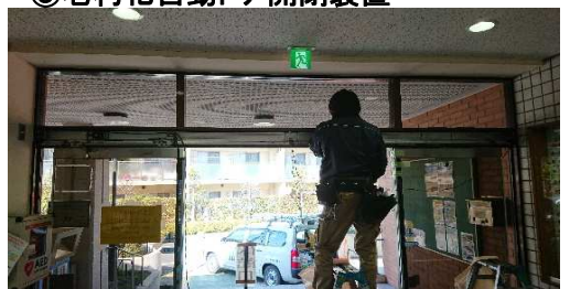
④自動ドア開閉装置撤去
