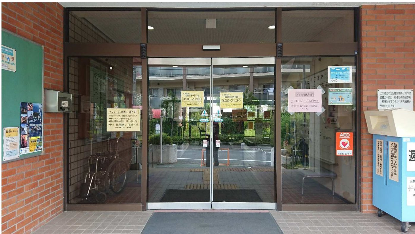
自動ドアフロント外観 アルミブロンズ 100 見込み自動ドアフロント 内外無目付けセンサ
