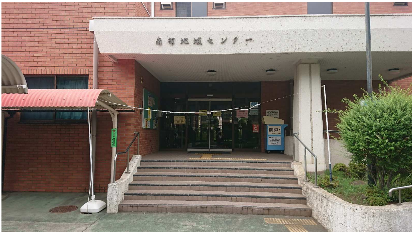
自動ドアフロント外観 アルミブロンズ 100 見込み自動ドアフロント 内外無目付けセンサ
