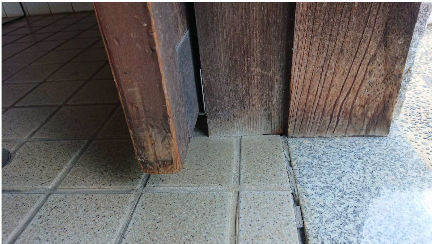
逆さ振れ止めの様子
