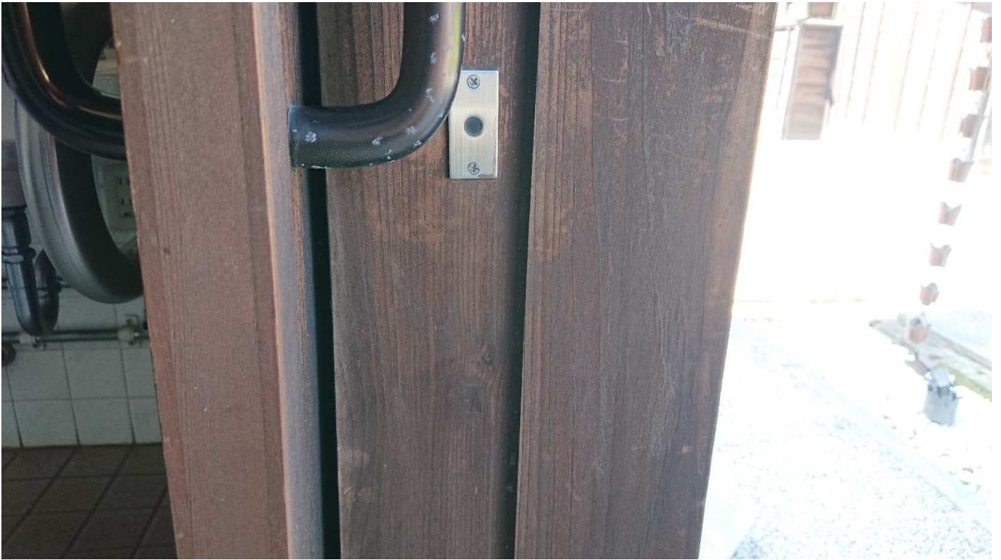
補助光線センサ（対向1光線式）戸袋側
