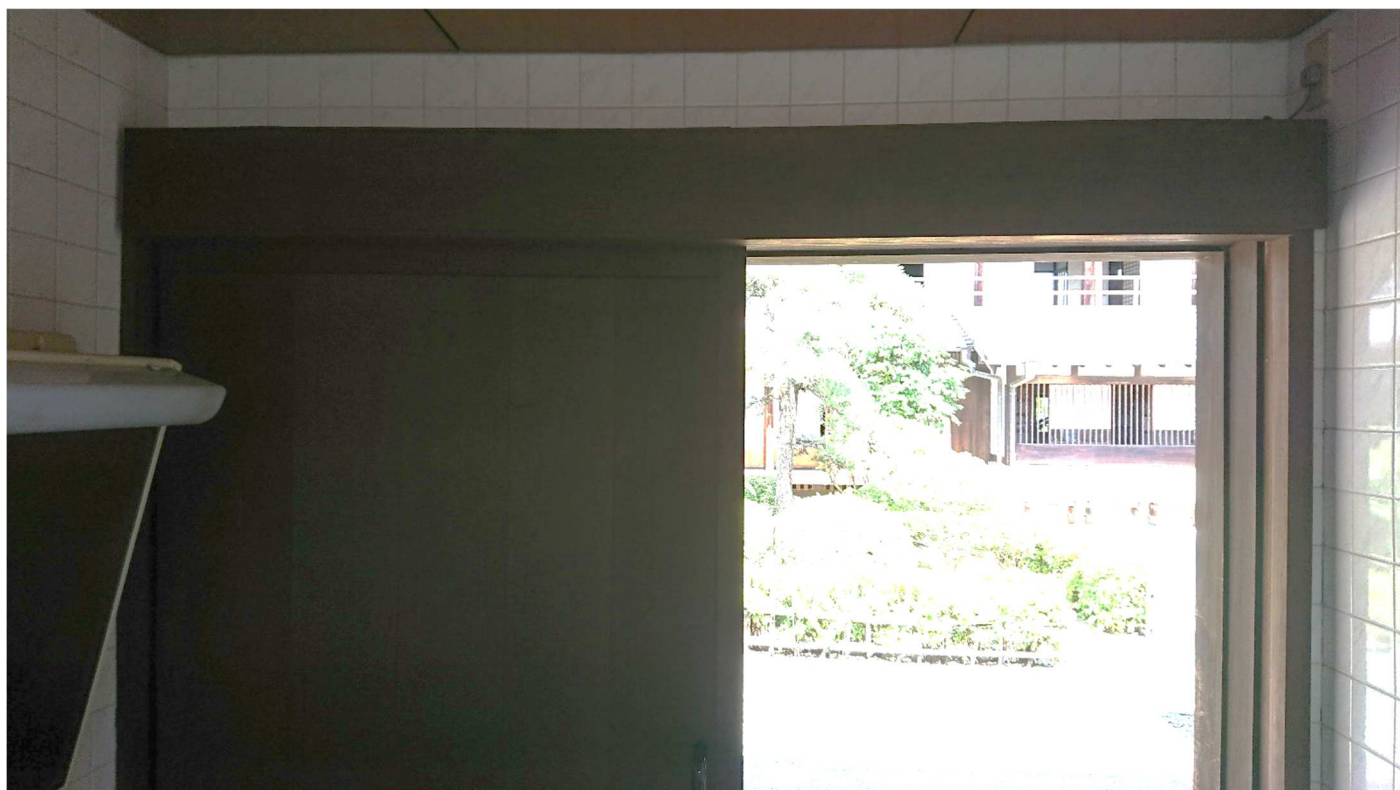
便房内より撮影
