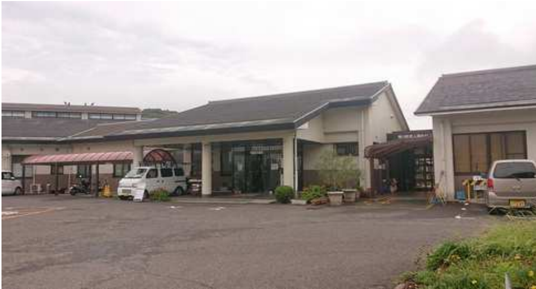
自動ドアフロント外観
