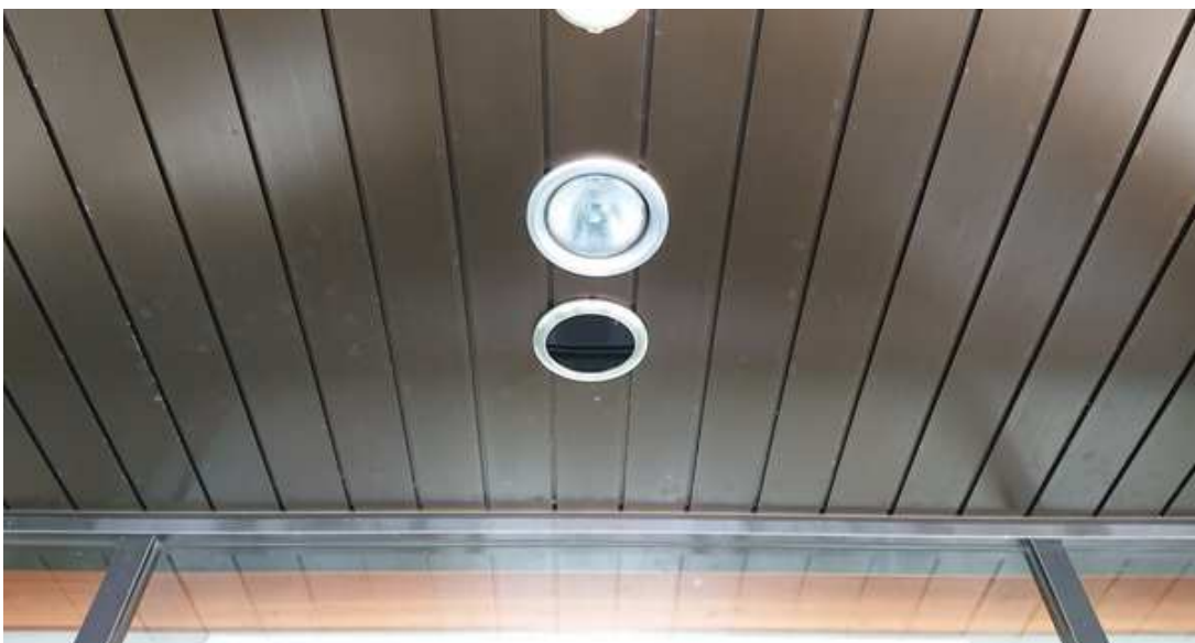
外側起動センサ（既存：天井埋め込み型）
