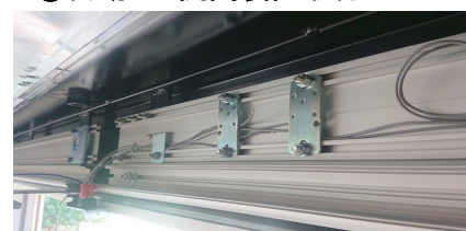
⑥ 自動ドア開閉装置取付
