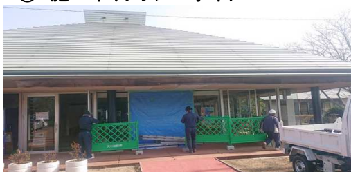
③ 施工中(自動ドア用サッシ)
