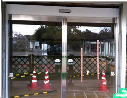
⑥ 自動ドア開閉装置取付
