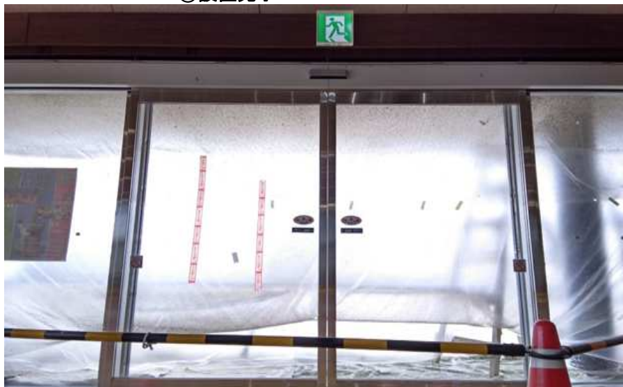
⑨ 設置完了
