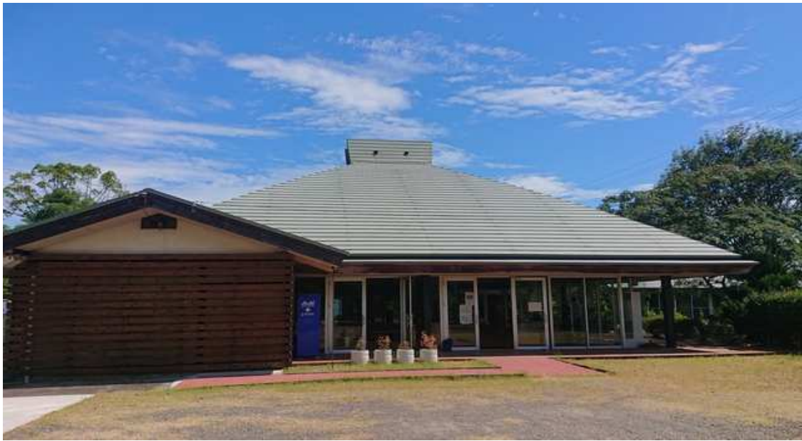
自動ドアへ変更箇所外観
