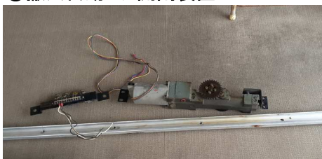
⑧ 撤去自動ドア開閉装置
