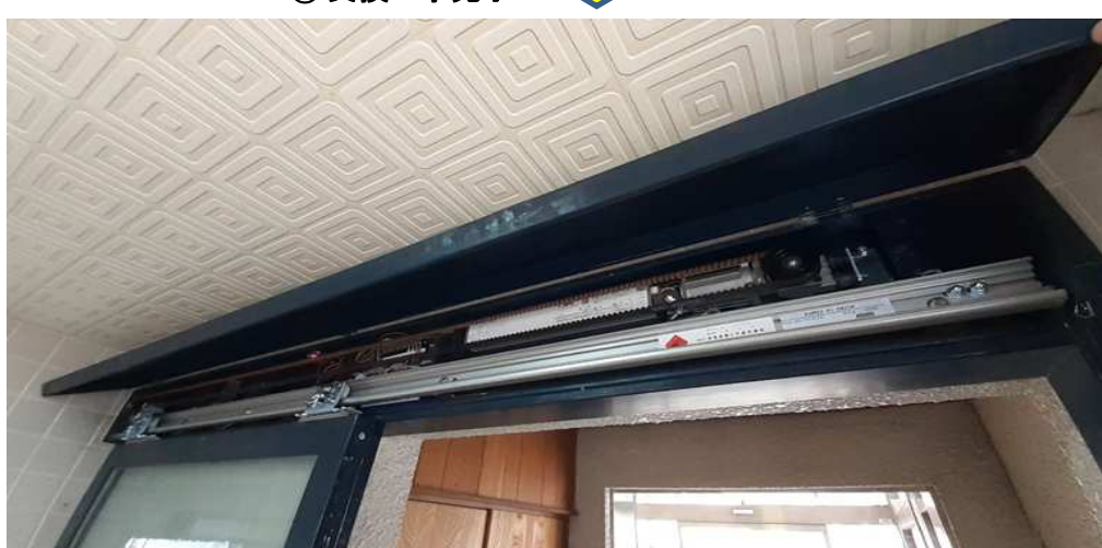
⑩ 交換工事完了
