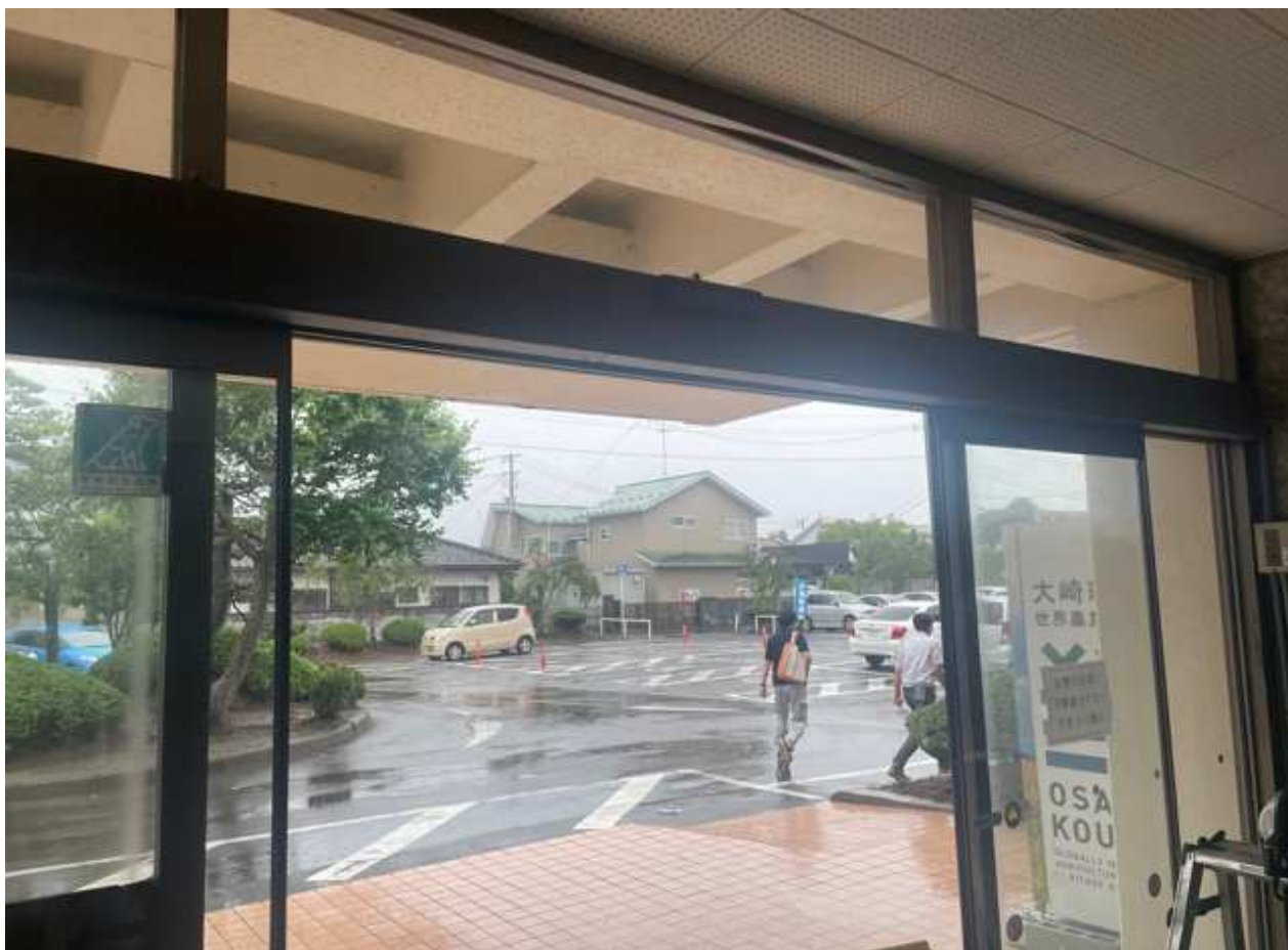
自動ドアフロント内観
