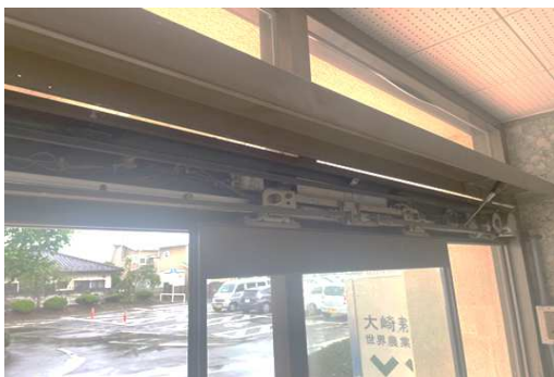
③ 撤去した自動ドア開閉装置
