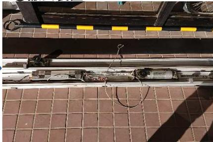
⑥補助光線センサ交換中
