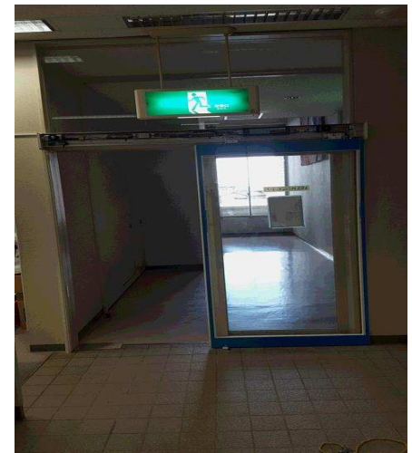
⑪ドア吊り込み調整
