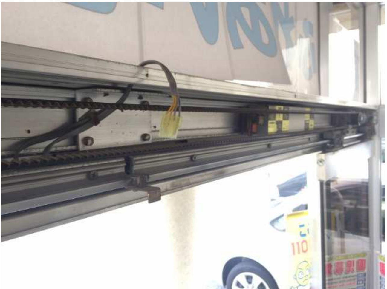
風除室外側自動ドア装置内部の様子↓
