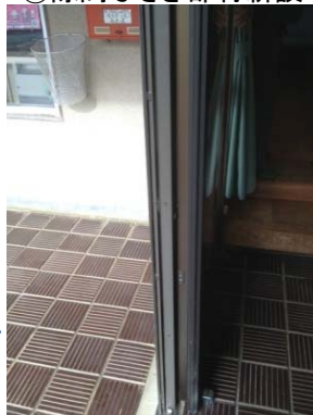
⑤隙間ふさぎ部材新設
