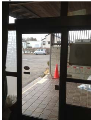
⑨施工後 内観
