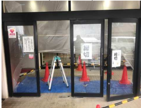
② 施工中(ヒンジ、ドア撤去)
