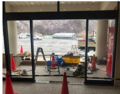
⑥ 施工中(自動ドア工事)
