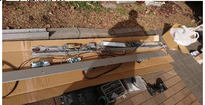
⑤ 施工中(配線、補助センサ取付)
