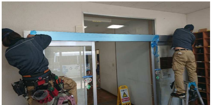
⑥ 施工中：自動ドア開閉装置カバー取付
