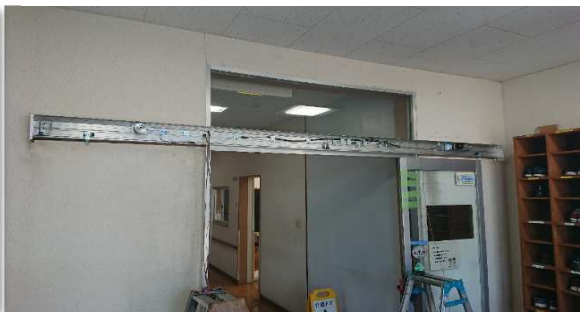
⑥ 施工中：自動ドア開閉装置カバー取付
