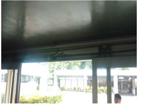
③ 老朽化自動ドア開閉装置
