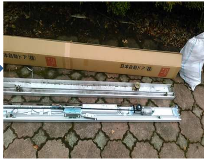
④ 新・旧 自動ドア装置
