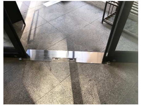
⑤ 施工中(フロアヒンジ補修)
