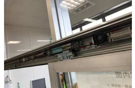
⑤ 施工中(新自動ドア開閉装置)
