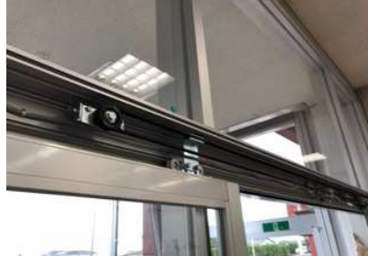
④ 施工中(新自動ドア開閉装置)
