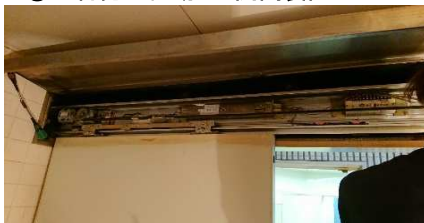
④老朽劣化自動ドア開閉装置
