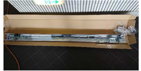
⑧施工中 新規自動ドア開閉装置
