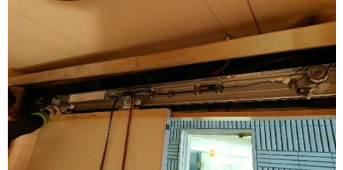
⑧施工中 新規自動ドア開閉装置
