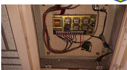
④老朽劣化自動ドア開閉装置
