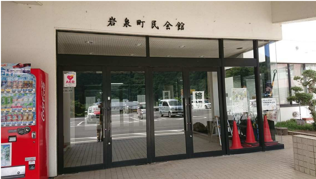
外観 扉を全開した状態
