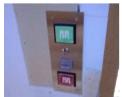
⑤ 施工中(押しボタンスイッチ)
