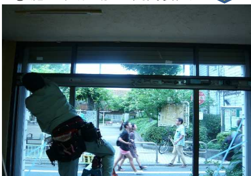
③ 施工中(自動ドア開閉装置)
