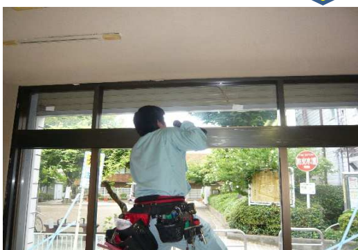
③ 施工中(自動ドア開閉装置)
