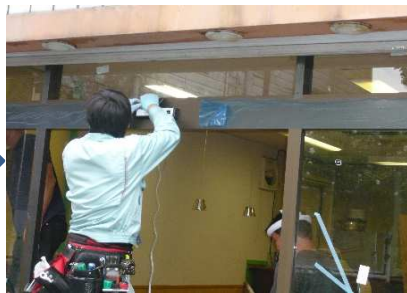
⑤ 施工中(ドア吊り込み、タッチスイッチ取付)
