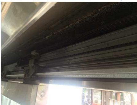
③ 老朽化自動ドア装置
