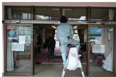
⑦ 新規装置取付工事中
