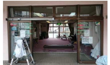
⑥ 新規装置取付工事中
