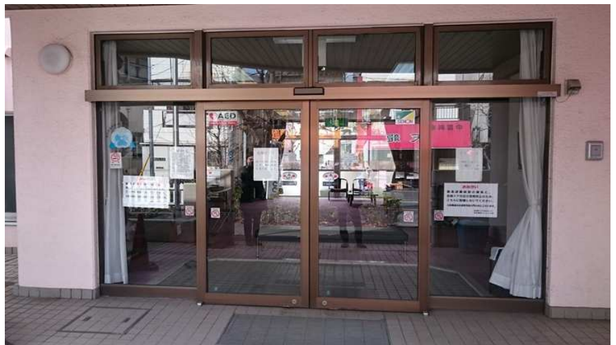
⑨ 設置完了
