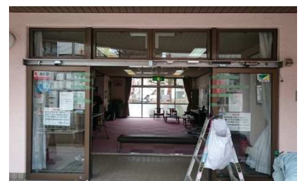
⑧ 新規装置取付工事中
