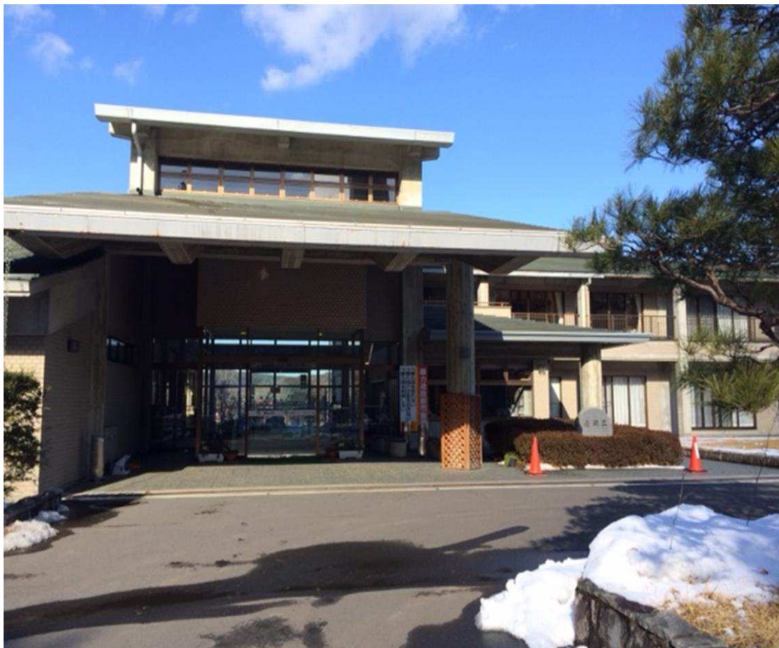
郡山市高齢者文化休養センター逢瀬荘 様 自動ドア装置交換工事他 建物外観
