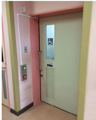
④ 施工完了(外観)
