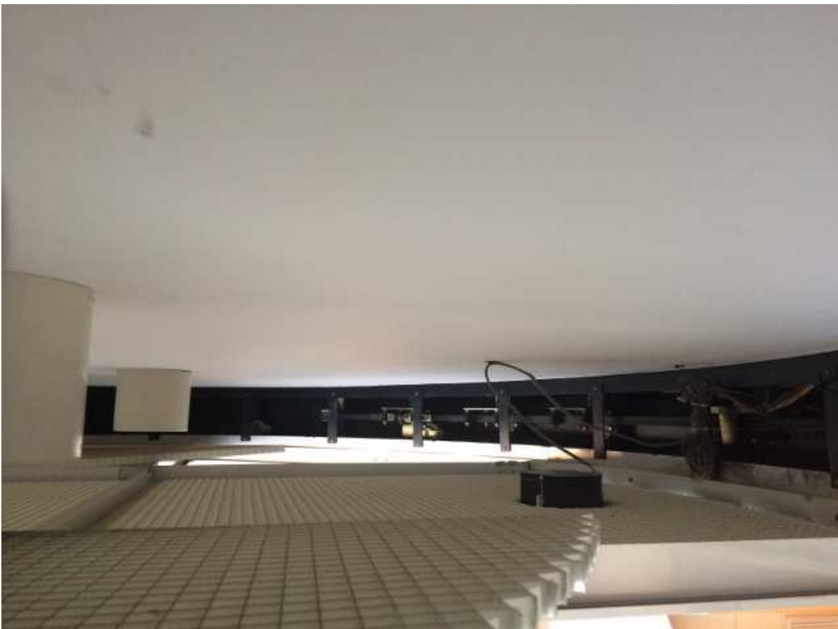
老朽化自動ドア装置
