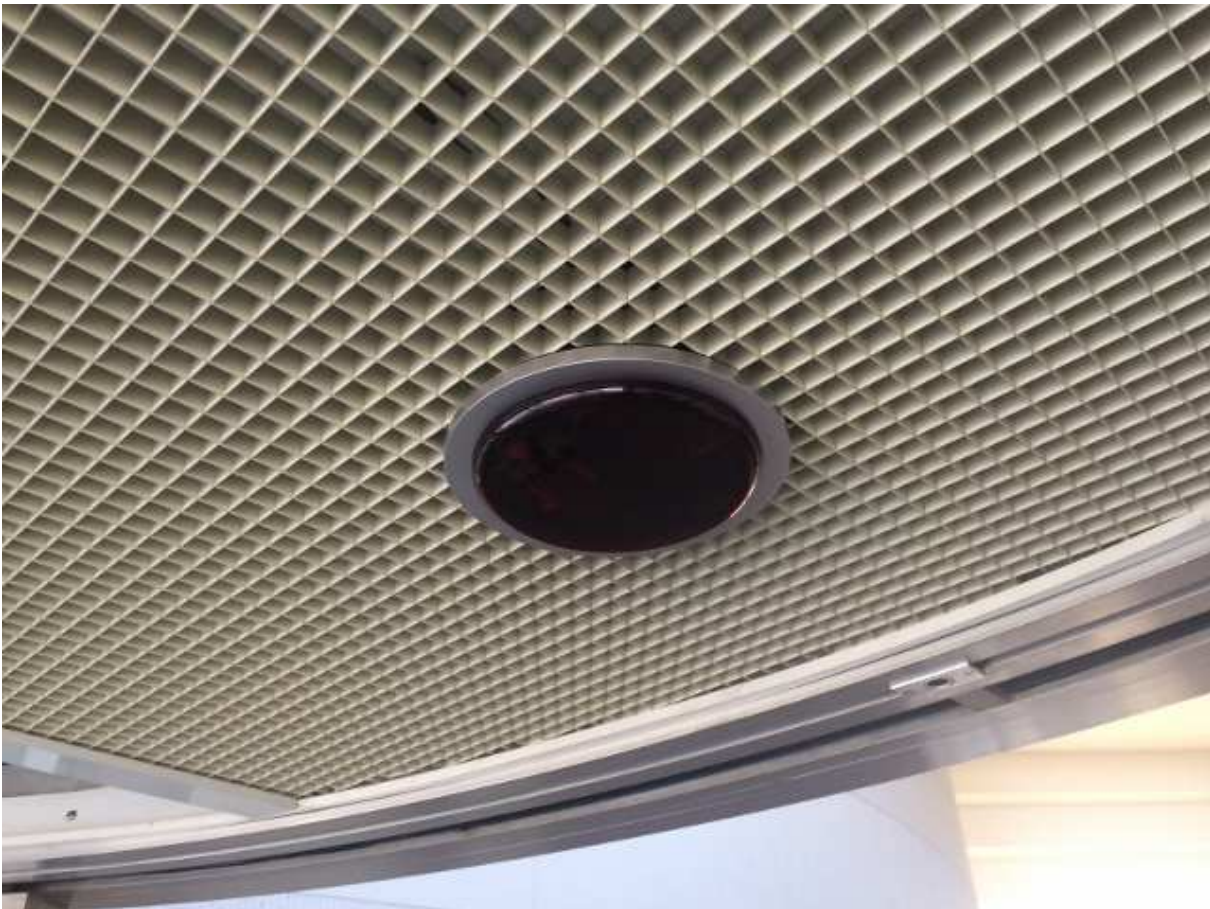
風除室内センサ（天井埋め込み型）
