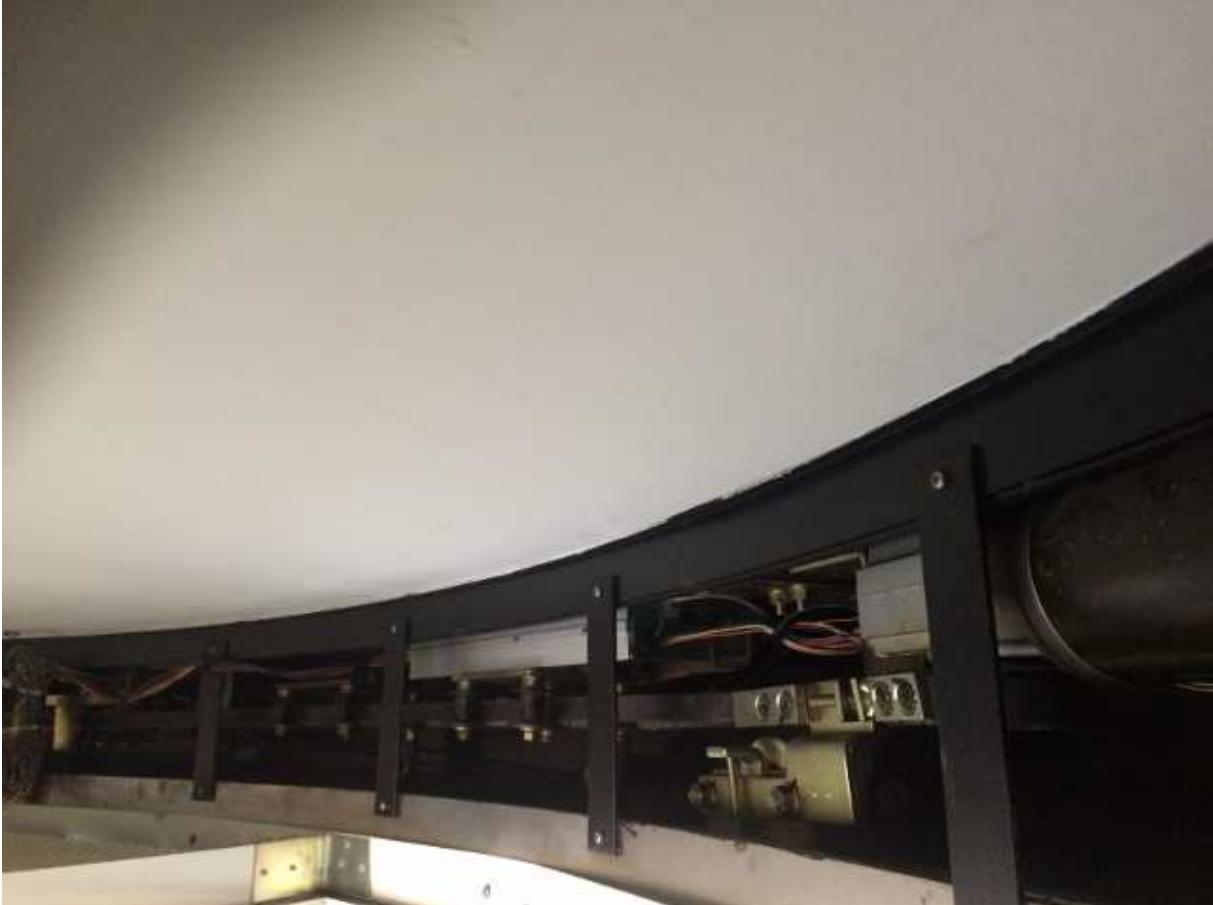
老朽化自動ドア装置
