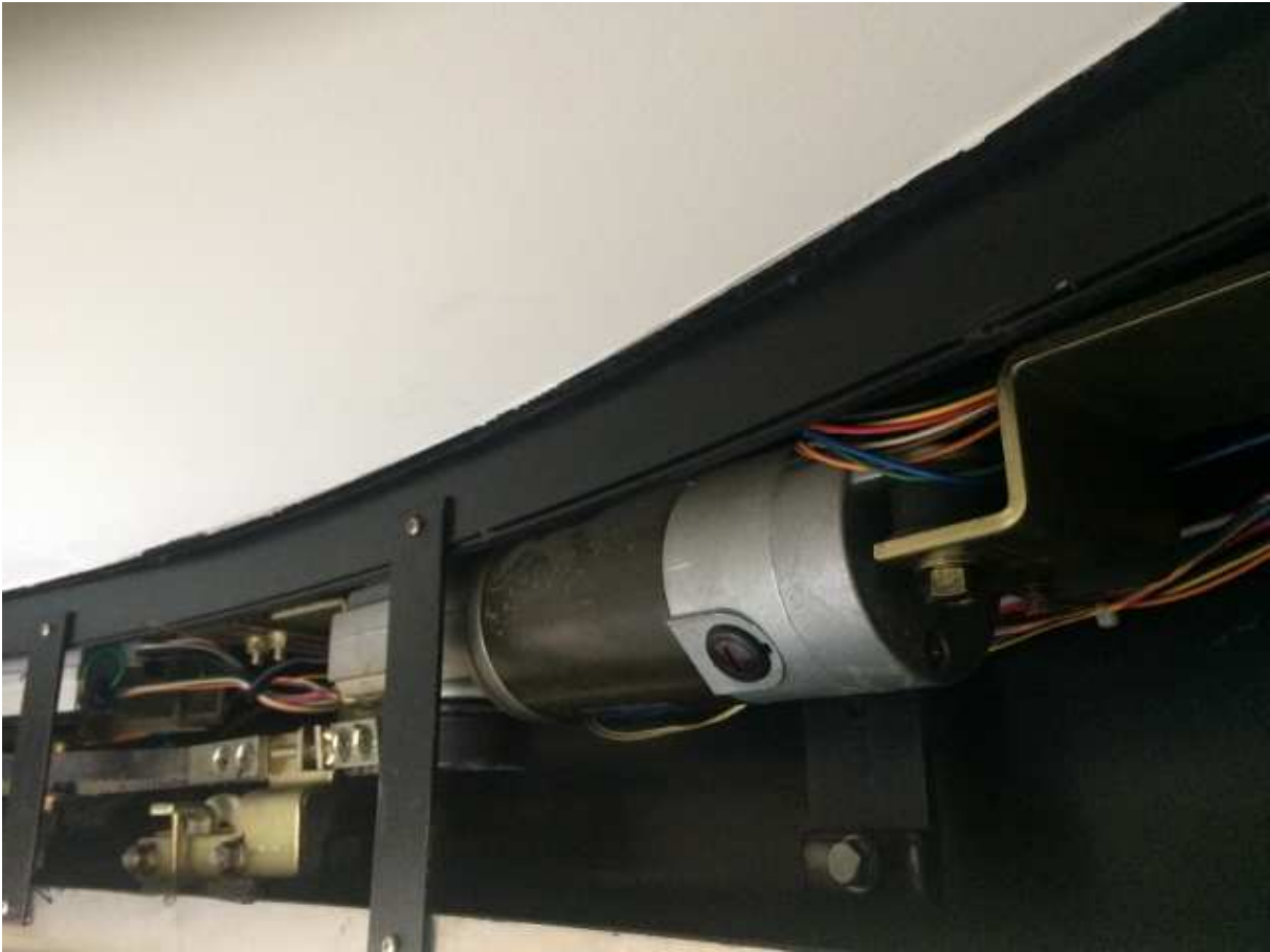
老朽化自動ドア装置
