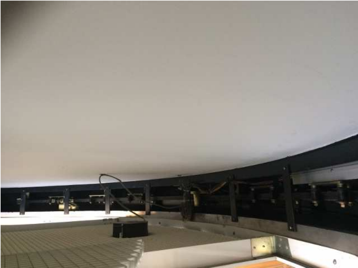
老朽化自動ドア装置
