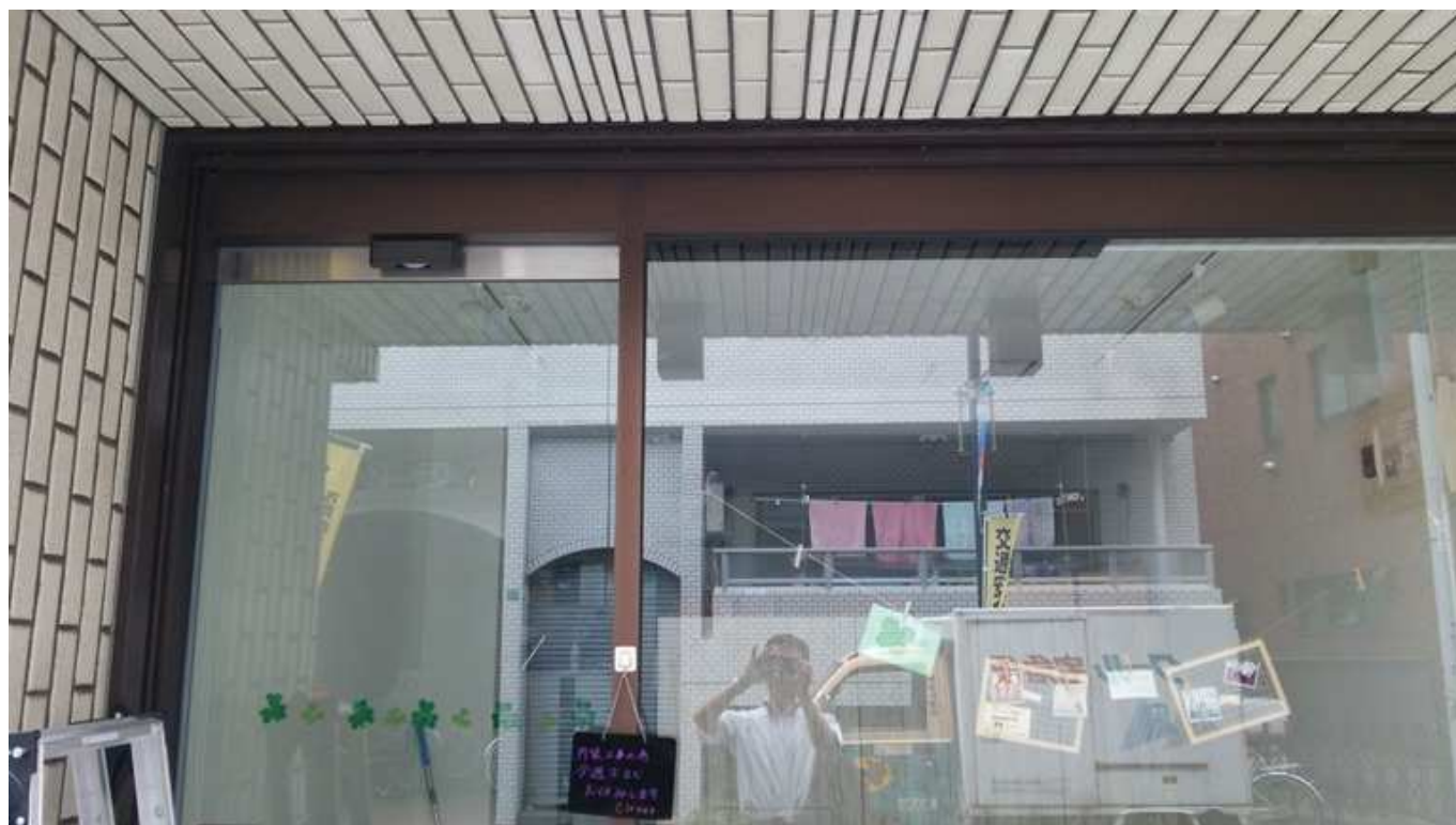
外側入口上部の様子
