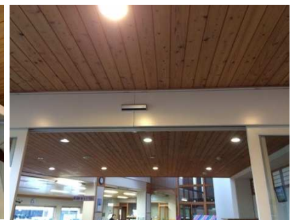
④ 施工中(新規センサ)
