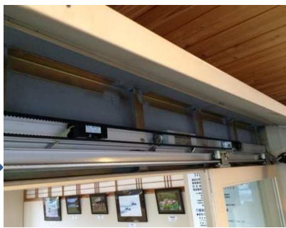
③ 施工中(新規装置)
