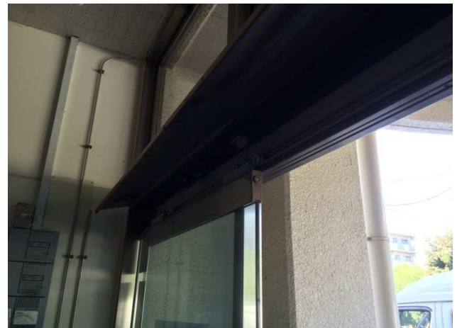
⑧ 自動ドア装置交換完了
