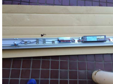
⑥施工中(ドア吊り)
