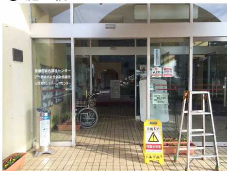
② 施工中(老朽化装置)
