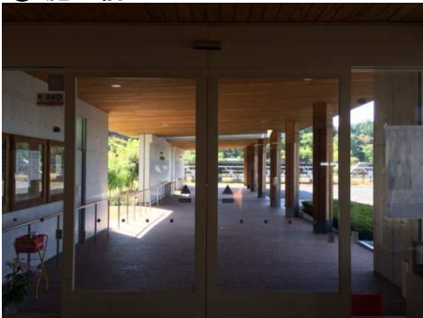
② 施工中(旧型装置)
