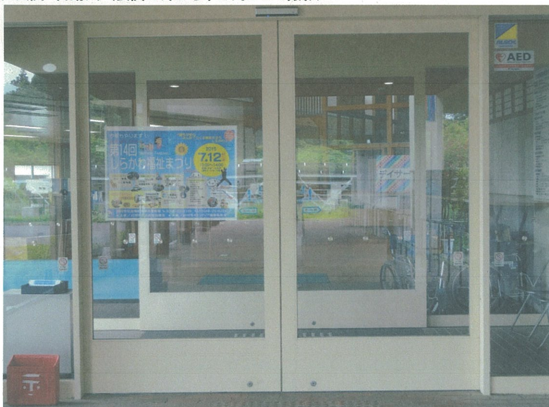
正面玄関 自動ドア(玄関の外から中に向かって撮影)
