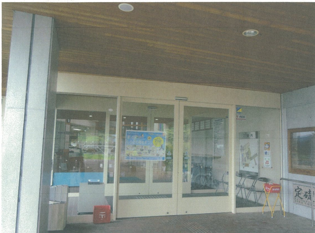
白河市表郷デイサービスセンター(福島県白河市) 正面玄関 自動ドア(玄関の外から中に向かって撮影)
