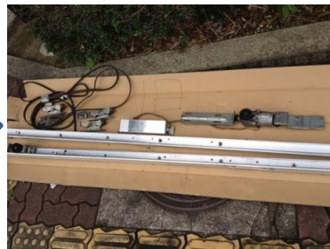
④ 施工中(旧使用材料)
