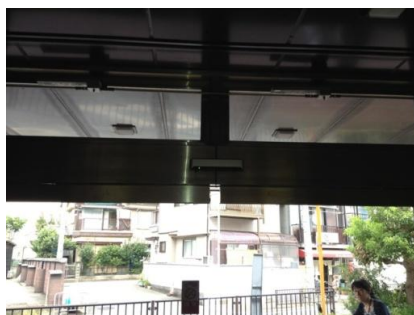
⑦ 設置完了
