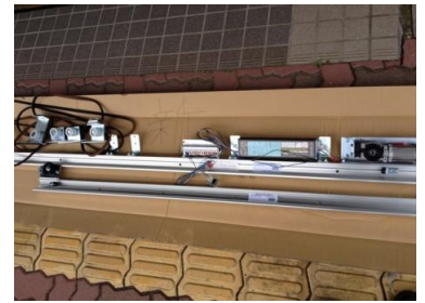
⑤ 施工中(旧使用材料)
