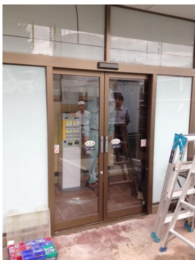
④ 自動ドア装置取付後
