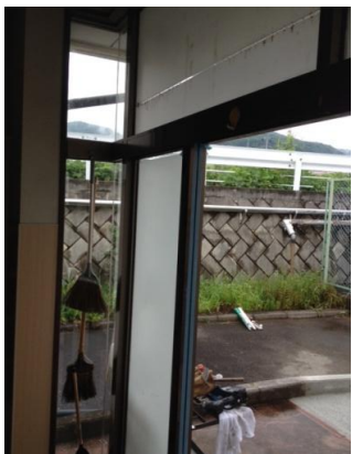
② 両袖隙間塞ぎ部材取付
