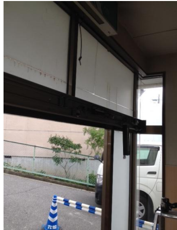
③ 自動ドア装置取付工事中
