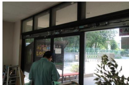
⑥ 自動ドア装置交換後
