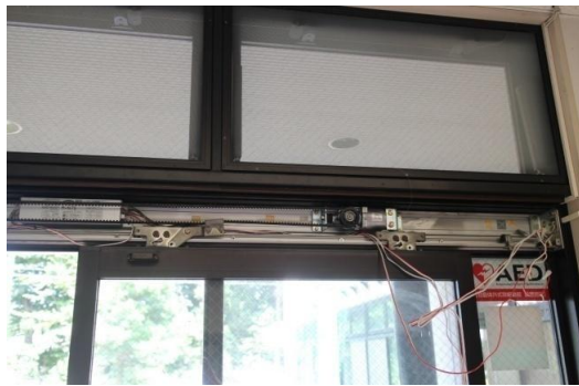
② 老朽化部品撤去中
