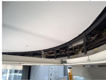
⑥施工中(新規装置)
