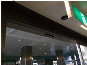
⑥ ドア吊り込み調整中
