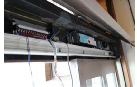
⑦ 補助光線センサ交換
