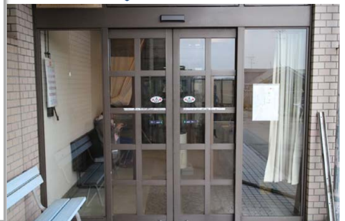
⑧ 設置完了
