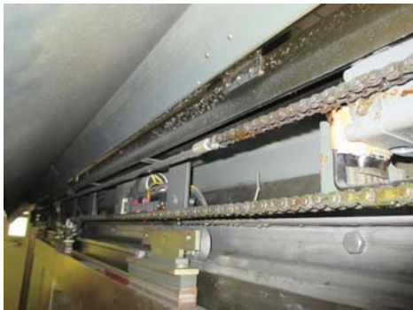
③ 自動ドア開閉装置撤去
