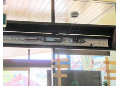
⑥ 補助光線スイッチ交換
