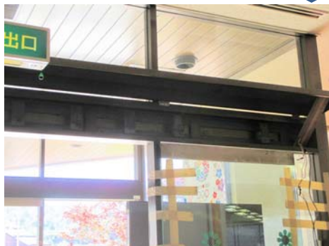
③ 自動ドア開閉装置撤去
