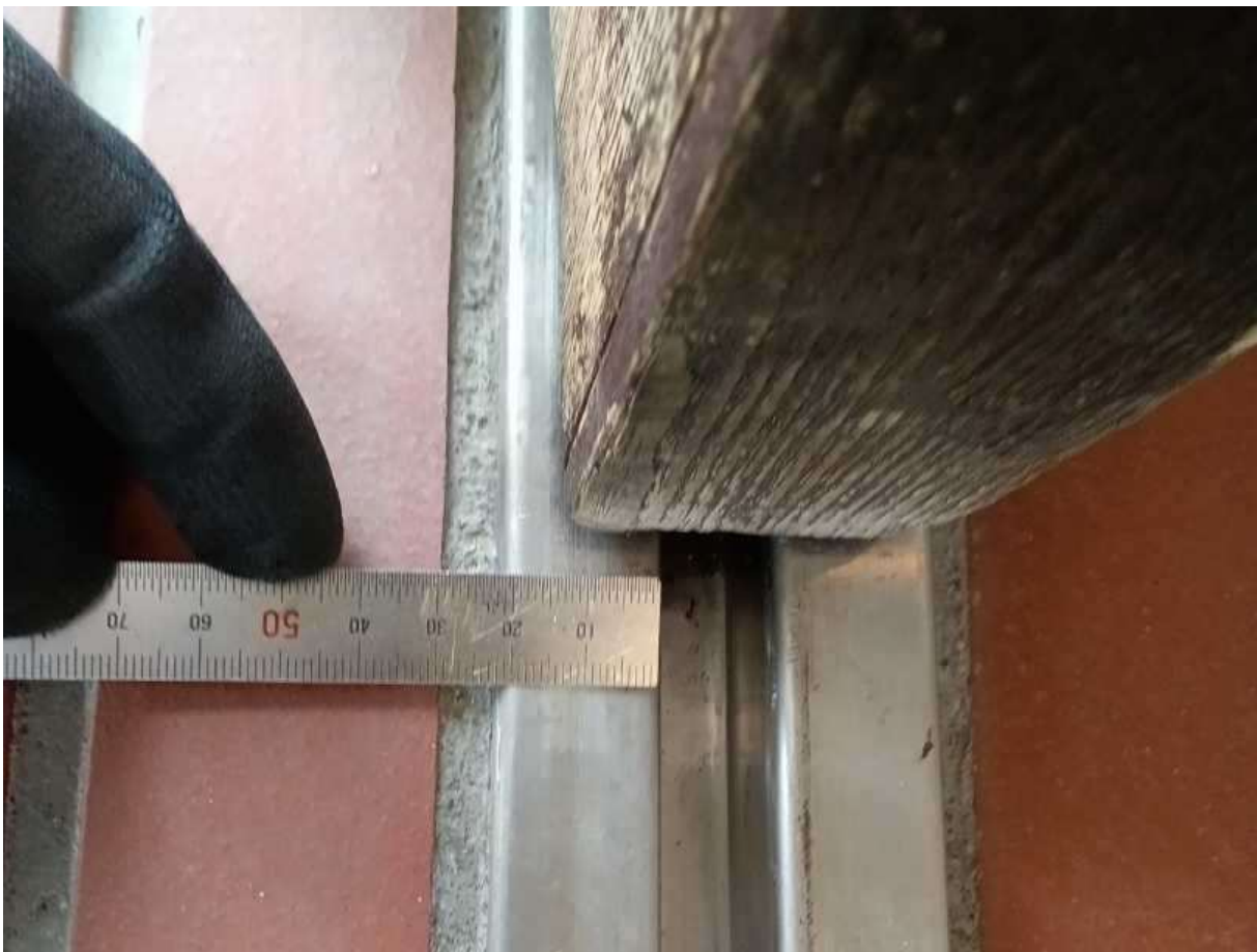
ガイドレールの状態 (溝幅 15 mm)
