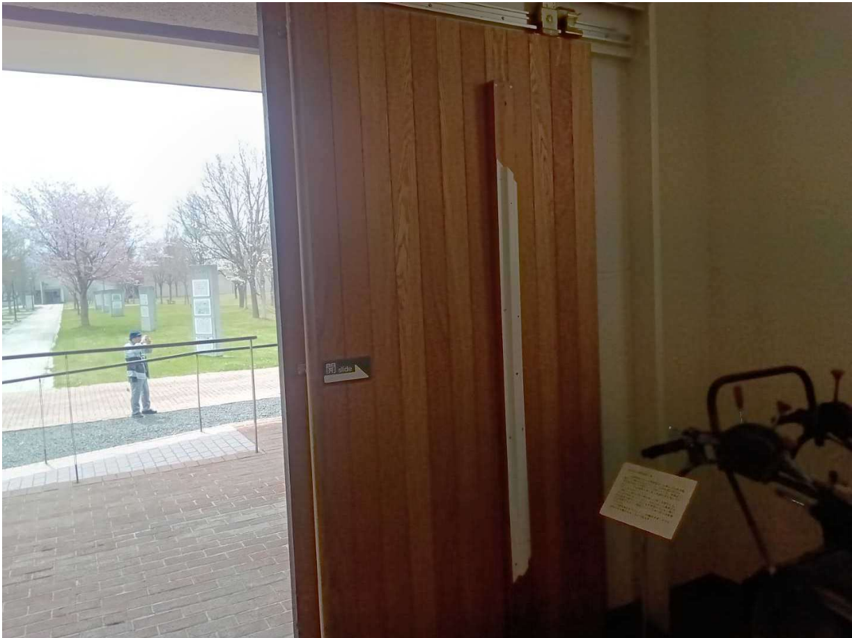
ガイドレールの状態 (溝幅 15 mm)
