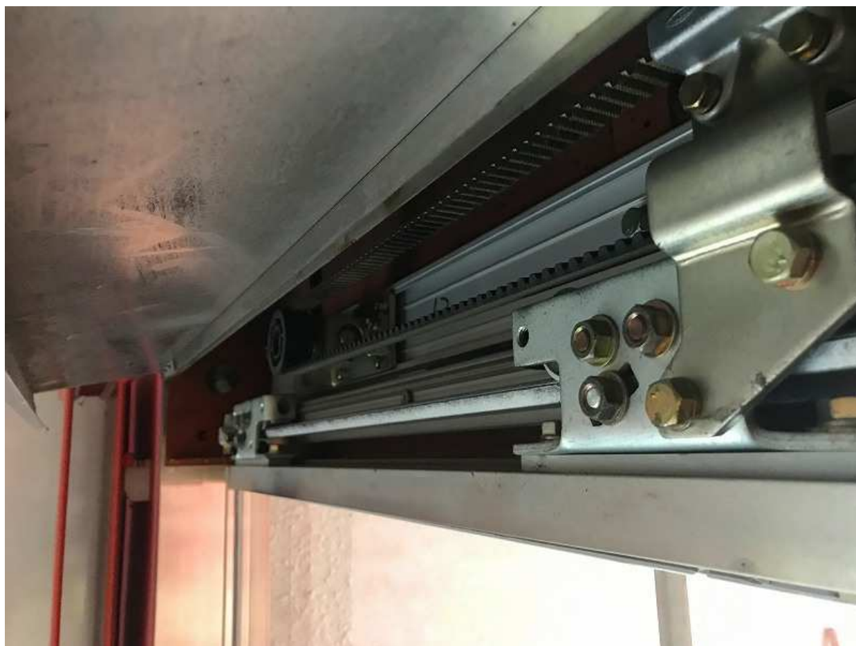
自動ドア装置内部の様子
