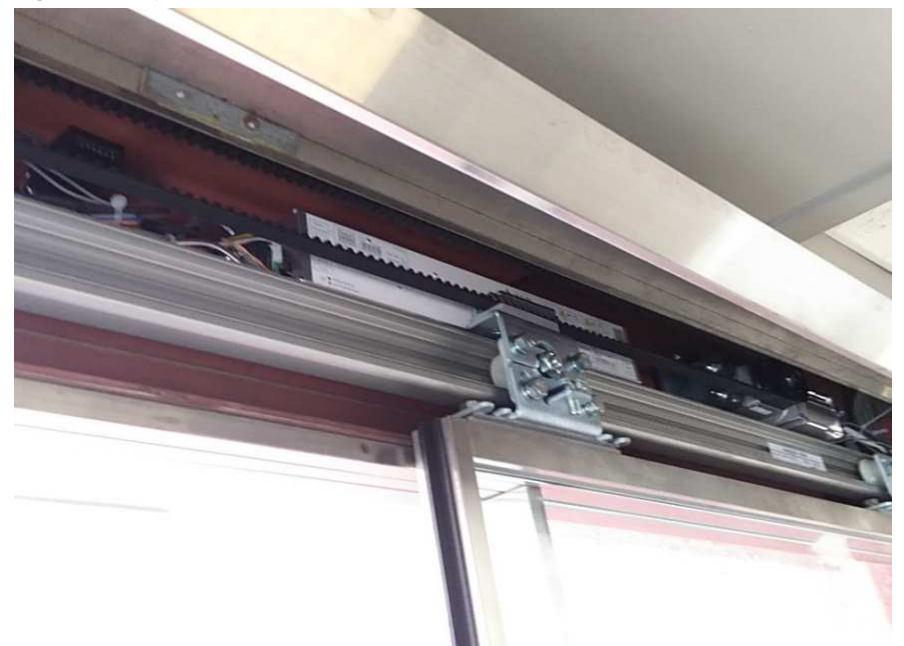
⑦自動ドア装置交換工事完了
