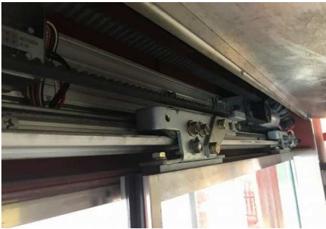
③老朽化自動ドア開閉装置撤去
