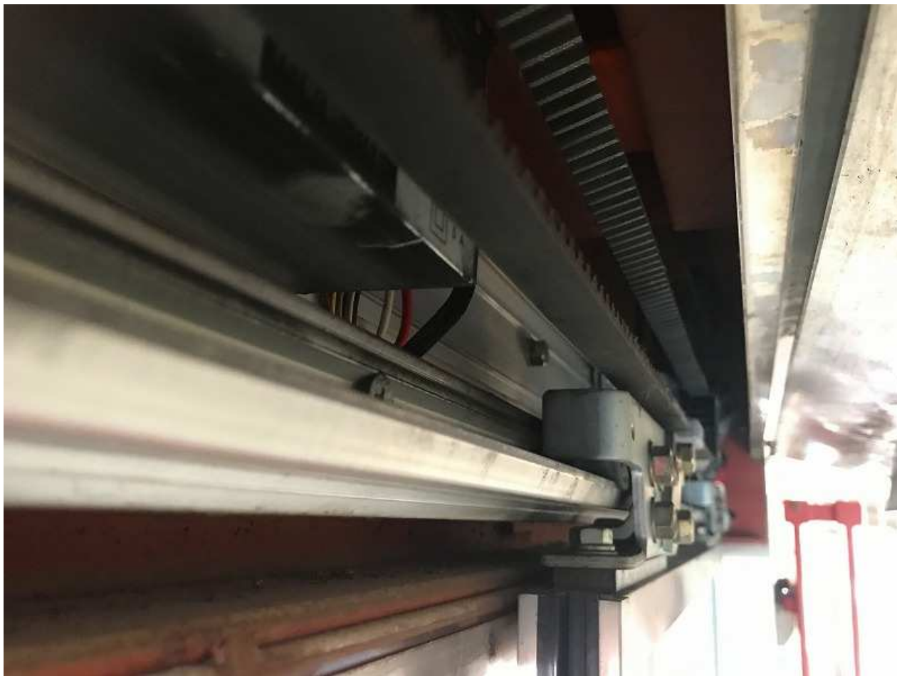
自動ドア装置内部の様子
