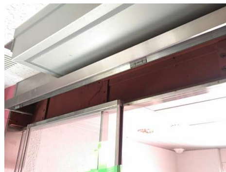
③老朽化自動ドア開閉装置撤去
