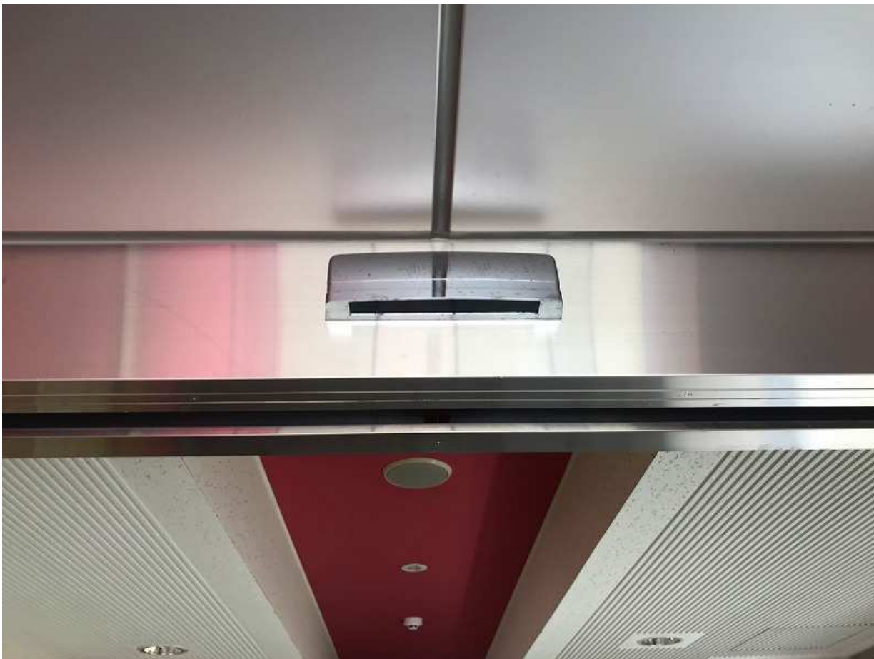
内部起動センサ（無目付けセンサ）
